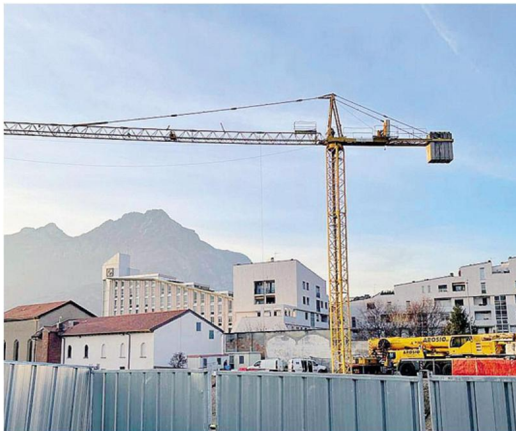
La gru montata nel cantiere del nuovo oratorio
